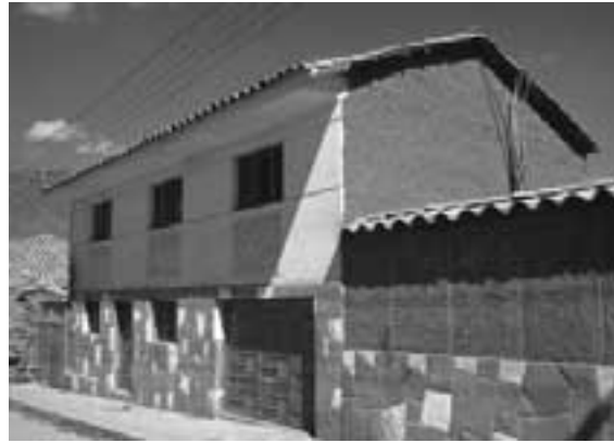
Casa de tipo B con un acceso bastante grande.
