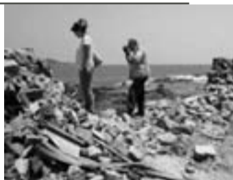
Les experts évaluent les dégâts aux remparts de la Vieille ville de Galle au Sri Lanka
