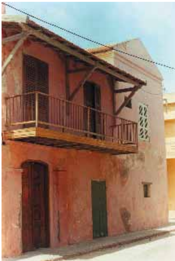
Une maison de Sidoni au Sud Vue extérieure
