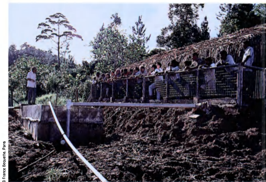
Le digesteur, nerf de la ferme intégrée: déchets végétaux et déjections animales y fermentent, produisant du biogaz et des résidus qui sont ensuite utilisés comme engrais.
