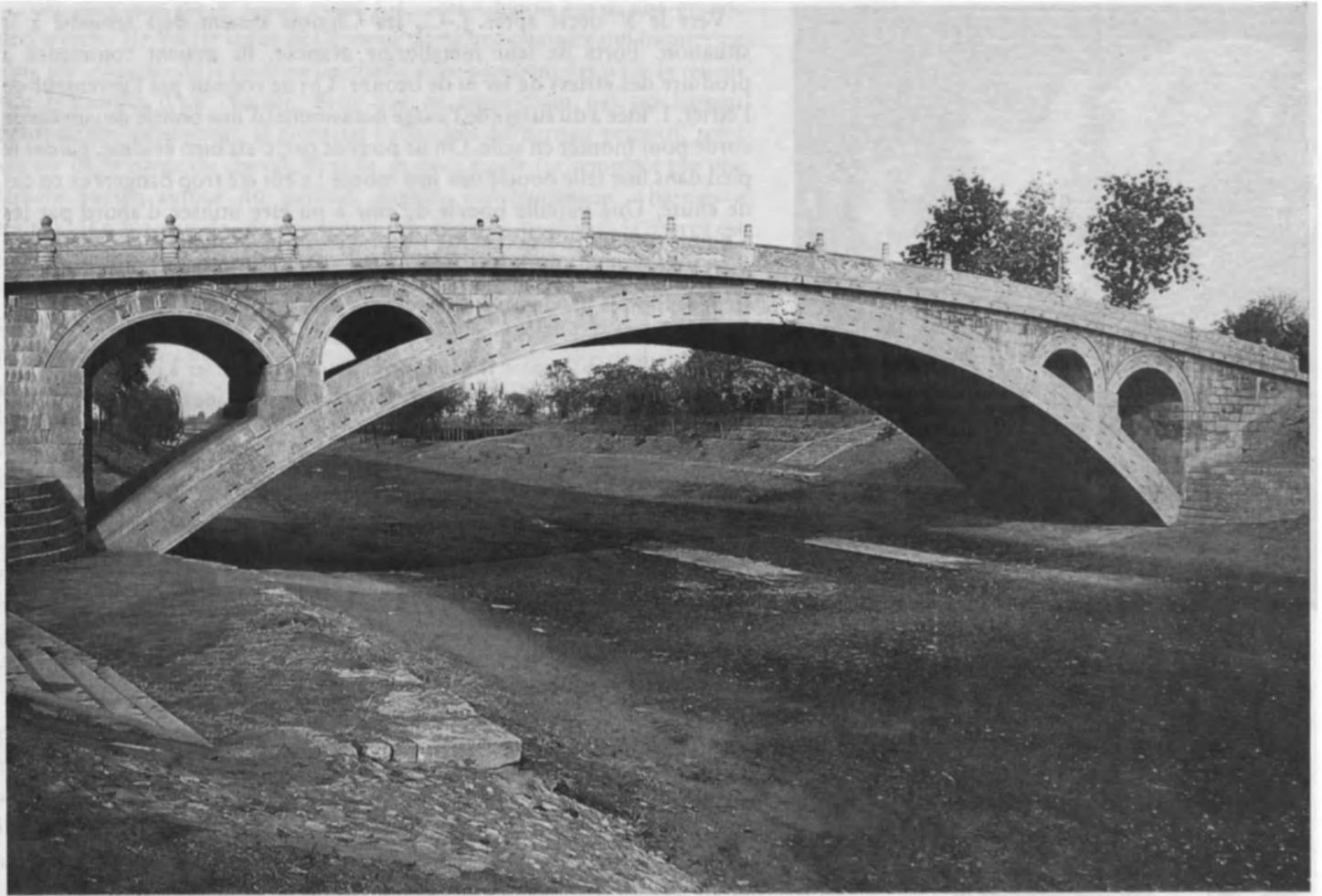
Le grand pont de pierre de la rivière Jiao. Construit en 610 après J.-C. et restauré au 20<sup>e</sup> siècle, il est toujours en service. Des agrafes en fer, avec le mortier, maintiennent les blocs de pierre.
